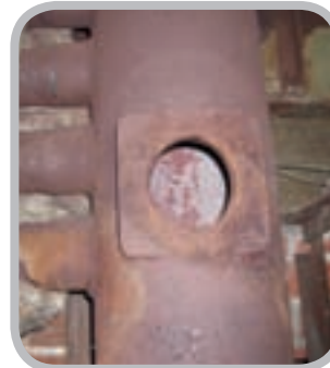
Reprise de portées de joint elliptique autoclave sur trou d'homme, trou de poing, trou d'oeil et chapelle de vanne
