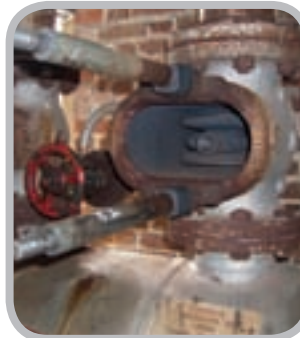
Reprise de portées de joint elliptique autoclave sur trou d'homme, trou de poing, trou d'oeil et chapelle de vanne
