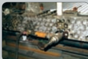
Réparation sur aéro-réfrigérants
