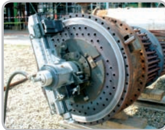
Surfaçage de portée de joint de faisceau
