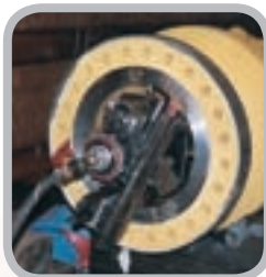
Reprise de portée de joint sur connecteur pipe-line (plate-forme de forage)
