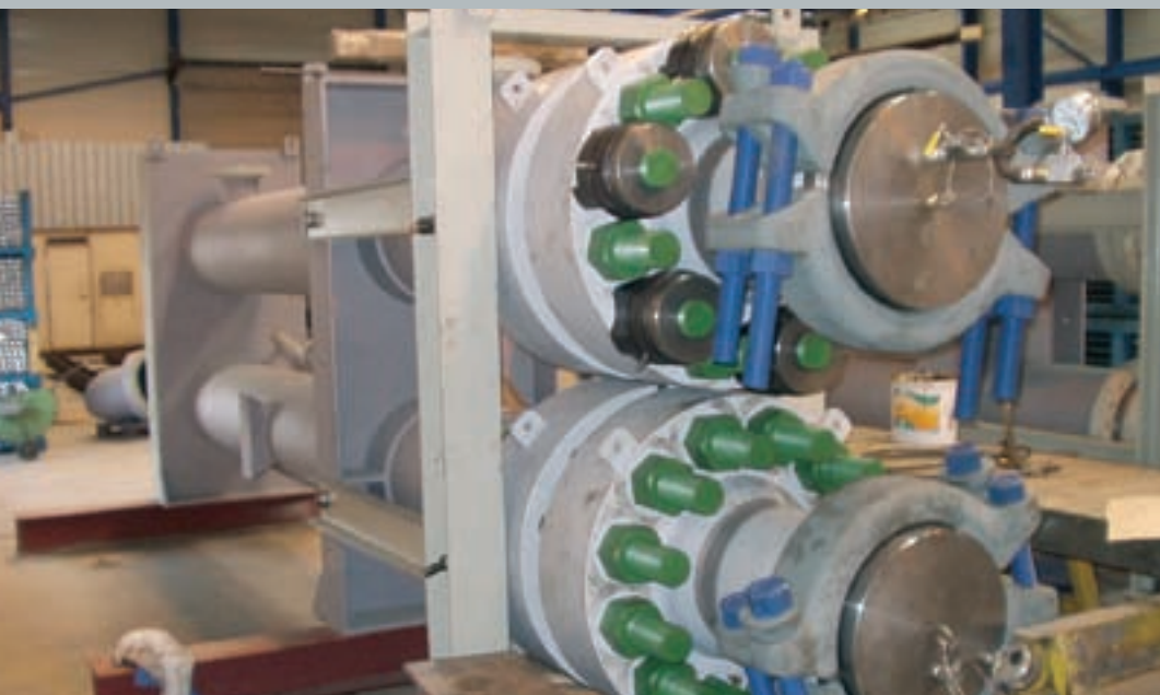
Serrage de tiges M95 sur échangeur avec 50% de tendeurs
